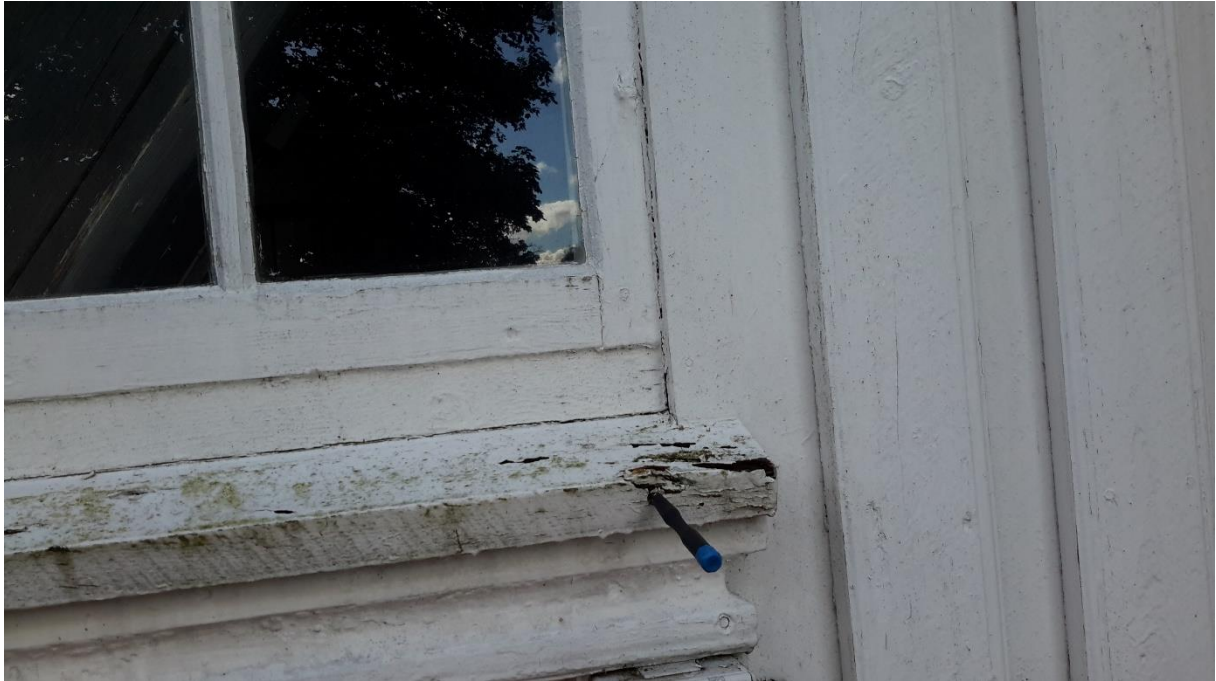
Vannbord råteskadet
