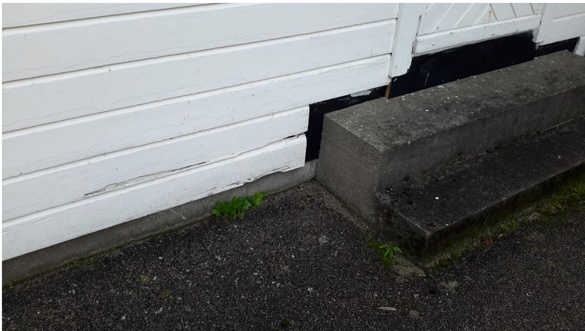
Litt råteskader
