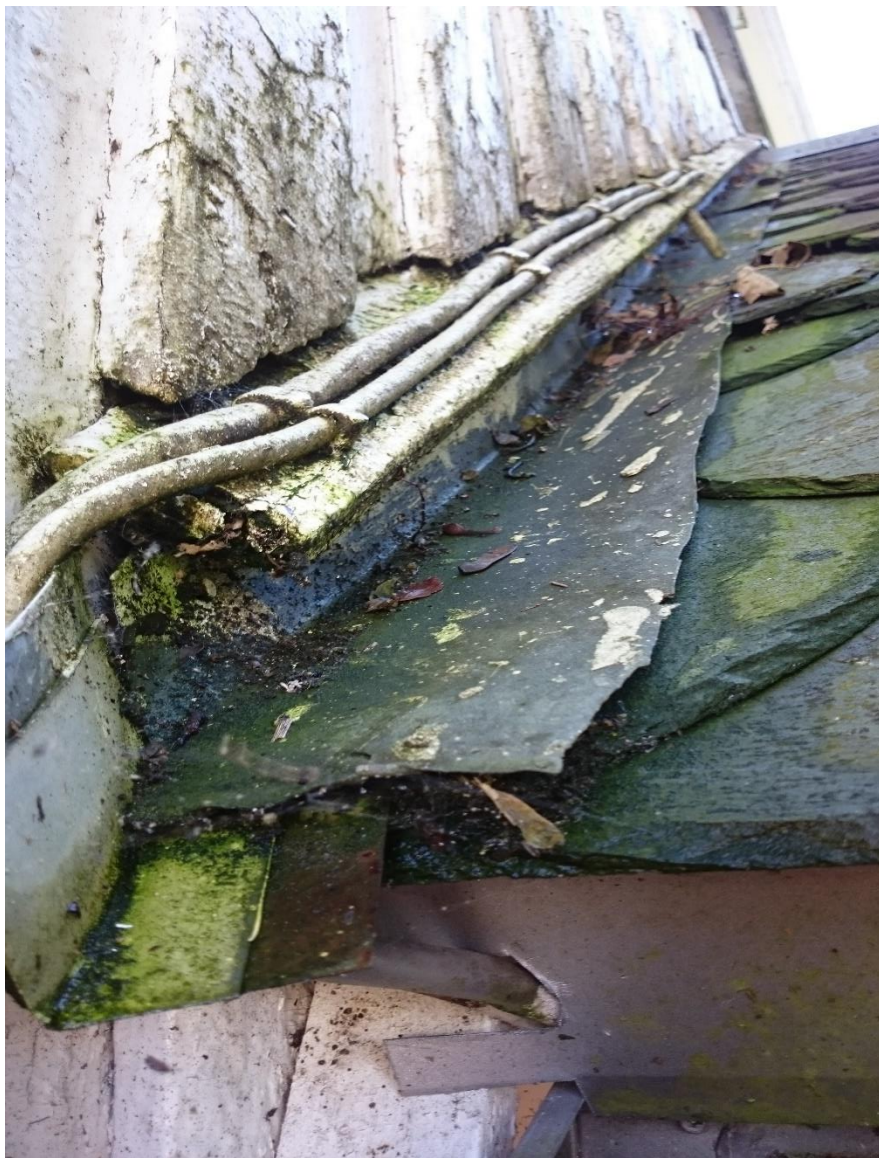
Over Våpenhus vegg/tak
