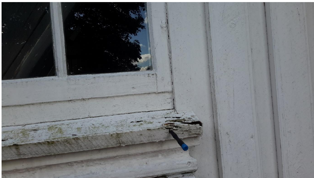
Vannbord råteskadet
