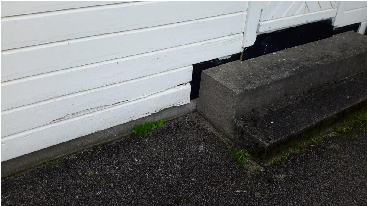
Litt råteskader
